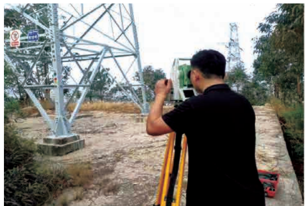
图 15 110KVA 高压铁塔沉降监测
