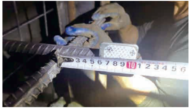
图 14 监控量测点埋设标准
