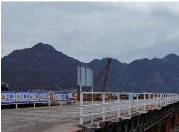
图5 专业化栈桥施工
