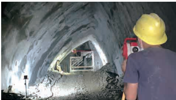
图 23 隧道开挖轮廓放样
