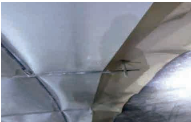
图 22 远离衬砌端二衬钢筋纵向水平筋固定
