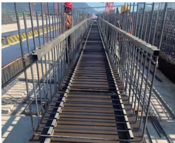
图 3 钢筋定位辅助
