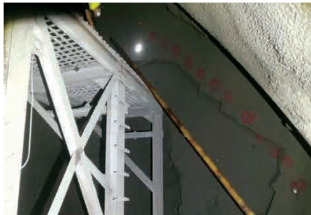
图 24 开挖爆破炮眼间距控制
