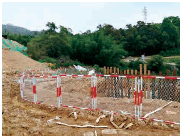
图6 基坑安全防护
