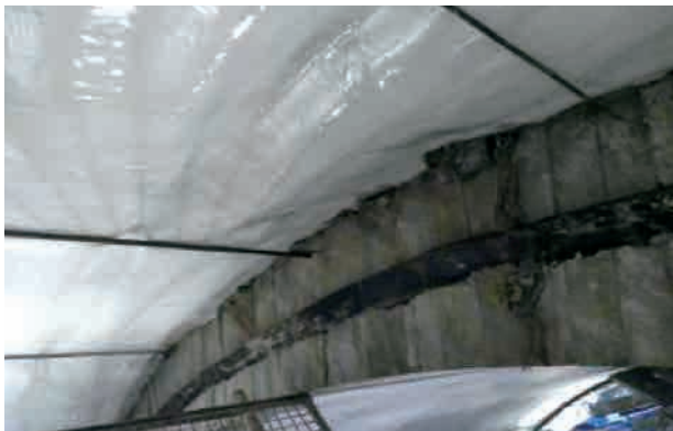
图 21 已浇筑二衬端二衬钢筋纵向水平筋固定
