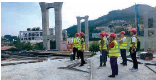
图 10 安全隐患排查
