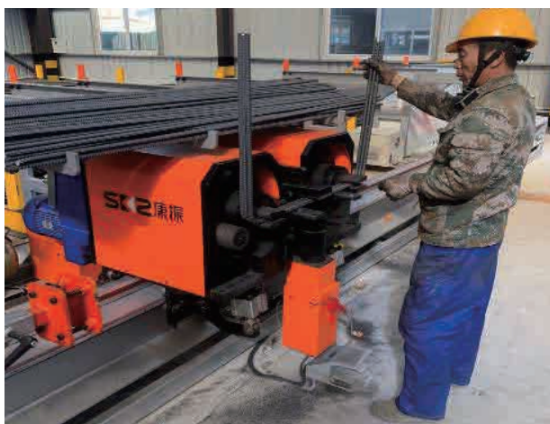
图 4 钢筋数字化加工
