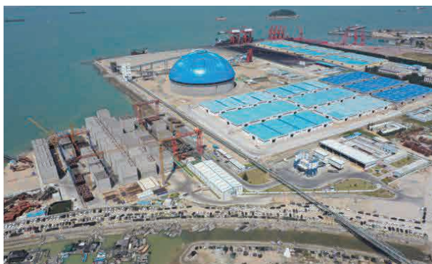
图 2-5 预制场建设实际航拍图
