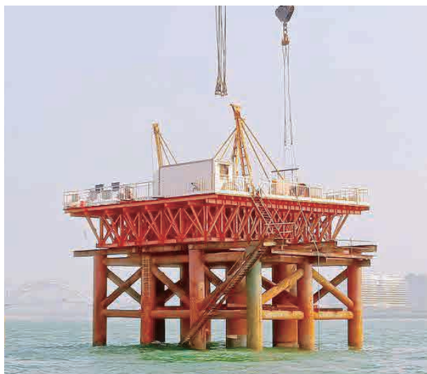
图4 一体化整体式钢平台
