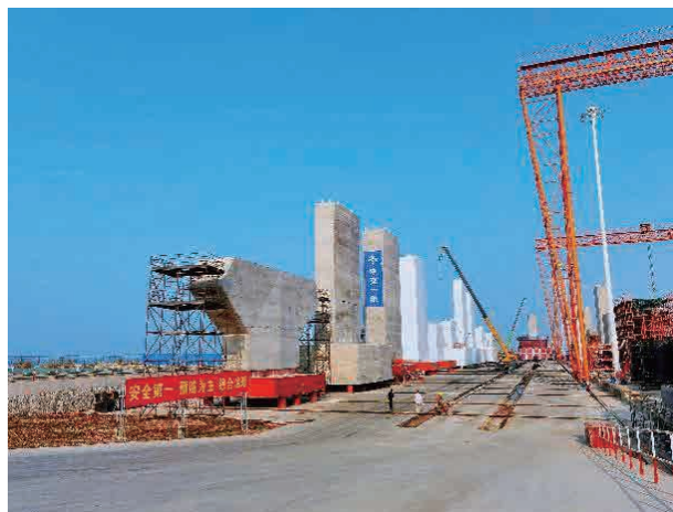
图5 预制装配式混凝土墩台技术
