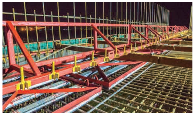
图 2-19 钢筋绑扎定位架
