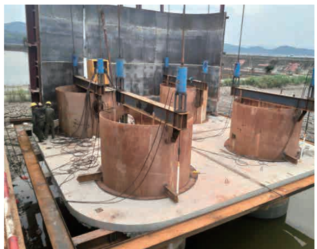
图7 壁板拼装
