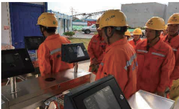
图 2-3 人脸识别进出施工现场
