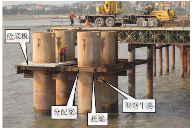
图6 混凝土底板拼装
