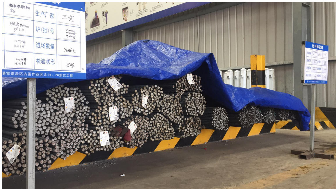
图 5.1.2 钢筋堆放场地
