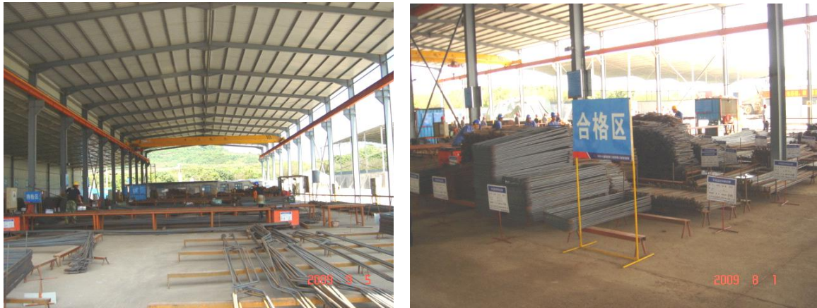
图4.1.4-1 钢筋及半成品堆放区
