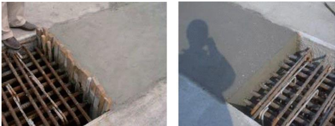
图 1.3.5-1 混凝土板施工缝的支模及拆模后的混凝土
