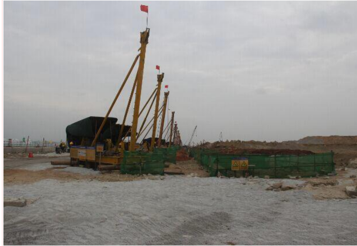
图 2.3.6-2 所有桩机按同一方向摆放且在同一直线上,进场时统一着色
