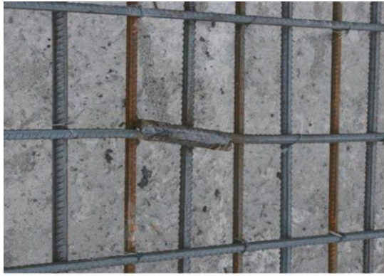
图 1.2.6-1 搭接焊
