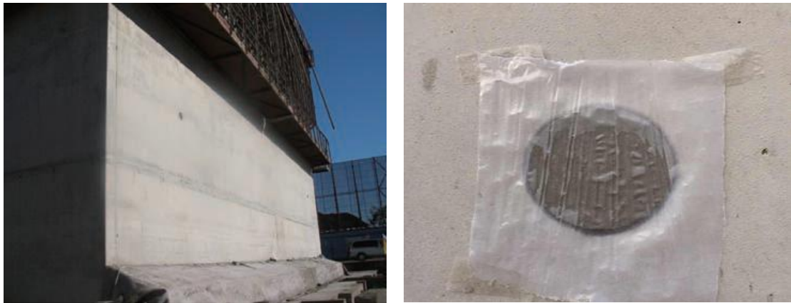
图 1.3.6-2 拉杆孔眼封堵
