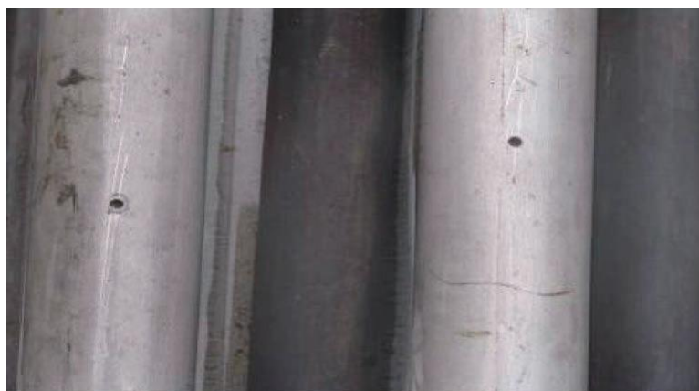
图 1.2.9-7 不锈钢电缆槽顶部开设排气孔
