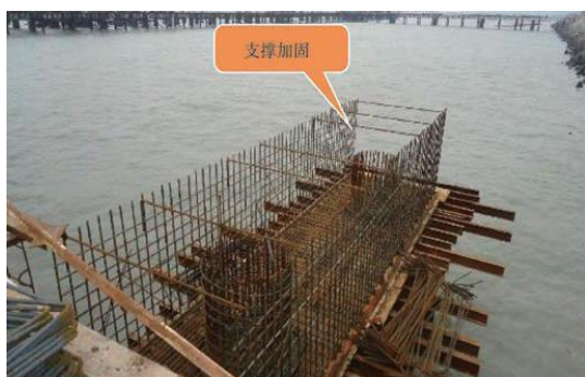
图 1.2.5-9 钢筋绑扎及加固
