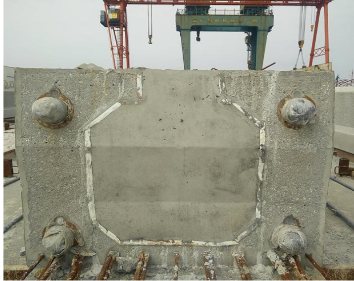
图 2.2.4-4 从预留浇筑口处浇筑砼
