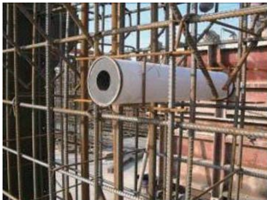
图 1.3.7-5 将橡胶封头安装于管端
