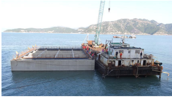
图 1.4.2-4 方驳定位安装
