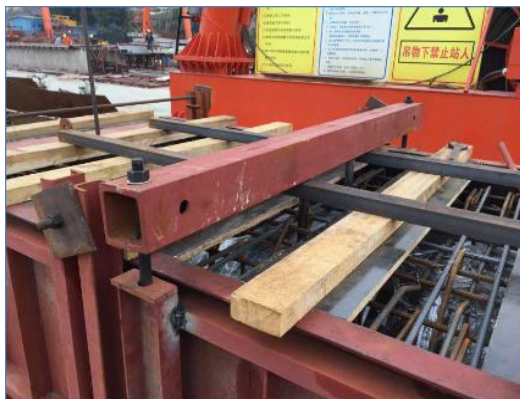
图 2.2.2-2 预制空心板顶部压槽工艺
