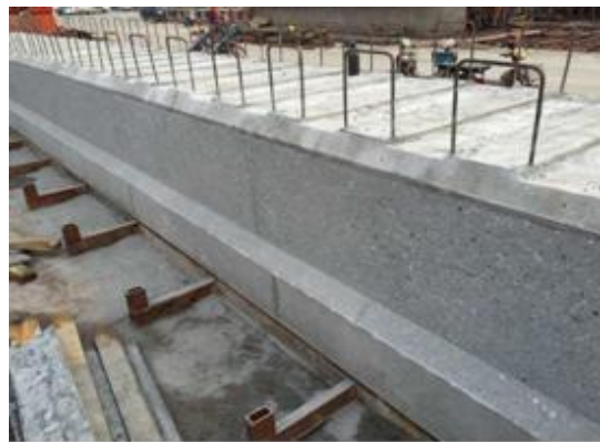
图 2.2.2-3 预制空心板顶部压槽效果
