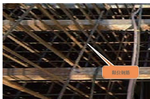
图 1.2.5-10 上层钢筋固定
