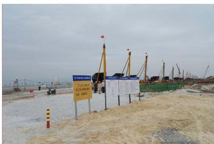
图 2.3.6-1 所有泥浆池前后沿防护标杆设置在同一直线上
