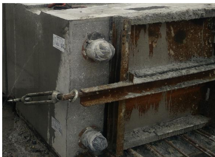
图 2.2.4-3 安装封端外钢模
