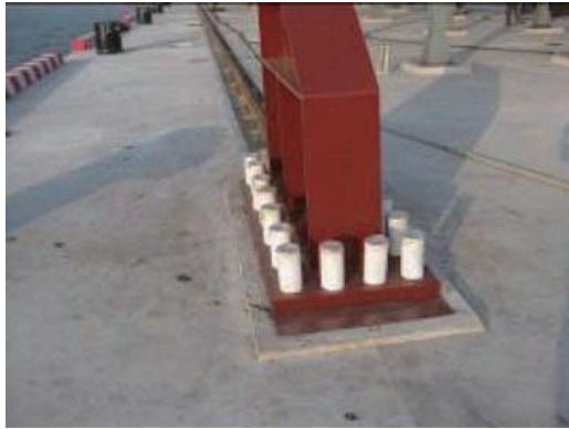
图 1.2.9-8 预埋件螺栓涂黄油、包塑料布、外加塑料套管保护
