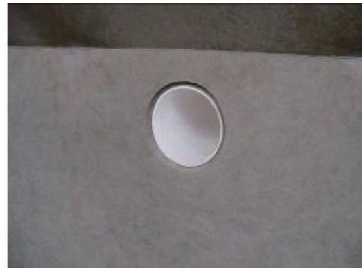
图 1.3.7-6 脱模后的孔质量
