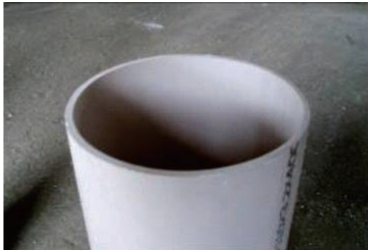
图 1.3.7-3 下料精确的 PVC 管端部
