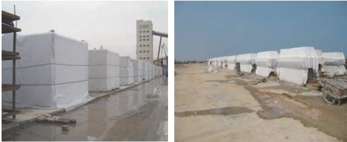
图 1.3.9-1 混凝土构件的养护
