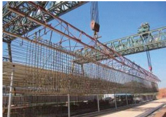
图 1.2.5-12 钢筋骨架吊运
