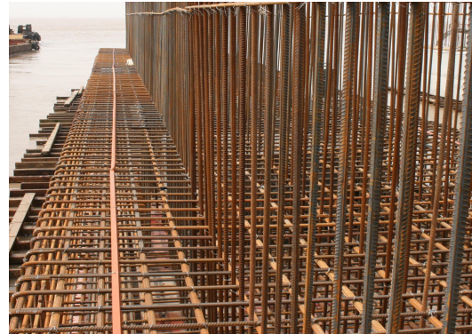
图 1.2.5-5 横梁定位卡模
