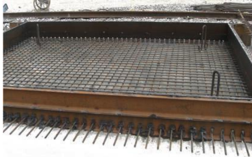
图 1.2.5-2 面层定位卡模
