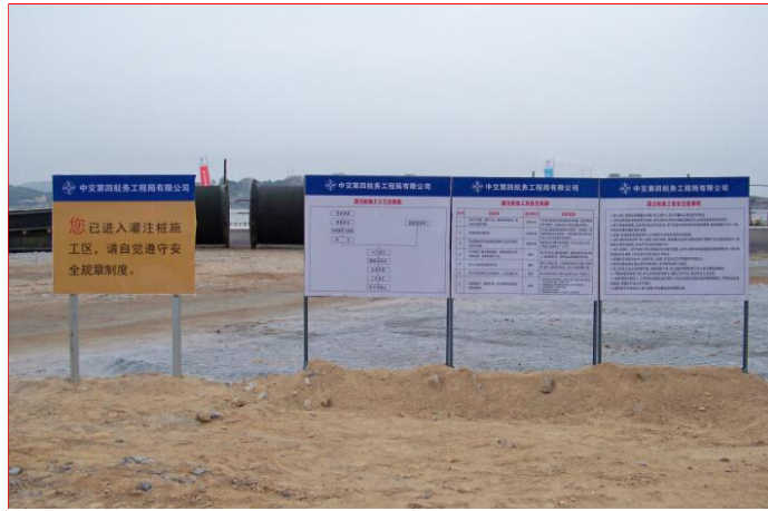
图 2.3.6-5 灌注桩施工工艺图、风险告知牌
