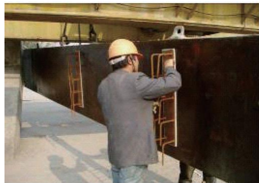
图 1.2.9-12 用螺栓将铁件与模板表面紧固
