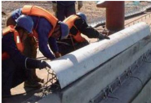
图 1.2.9-3 施工现场焊接安装护轮坎钢护缘
