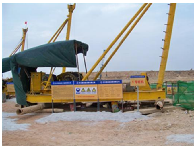
图 2.3.6-6 桩机编号牌、操作规程牌、冲孔记录牌
