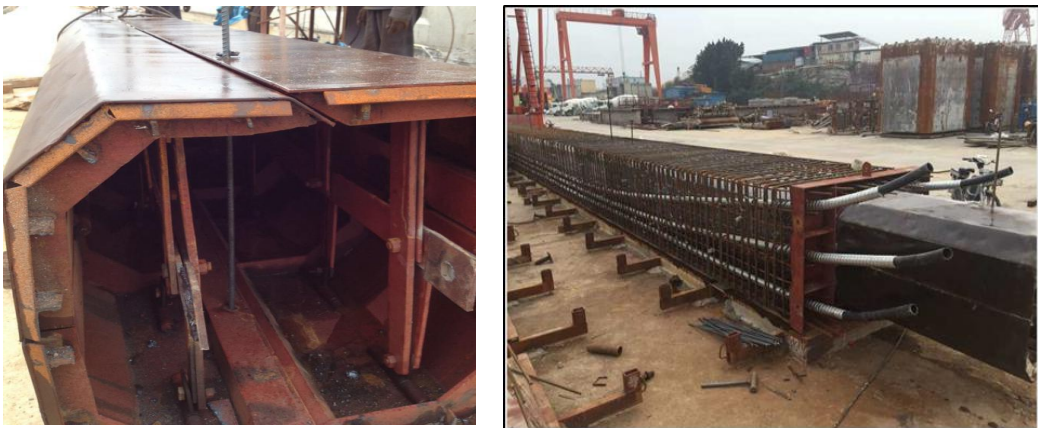
图 1.1.2-10 预制空心板可调节式刚性内模
