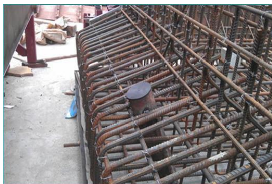
图 2.1.2-9 沉箱牵引孔设置及橡胶塞
