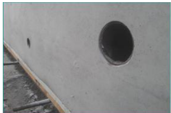
图 2.1.2-9 沉箱牵引孔设置及橡胶塞
