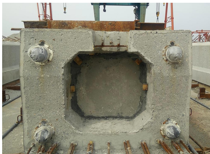
图 2.2.4-2 安装预制内芯混凝土挡板
