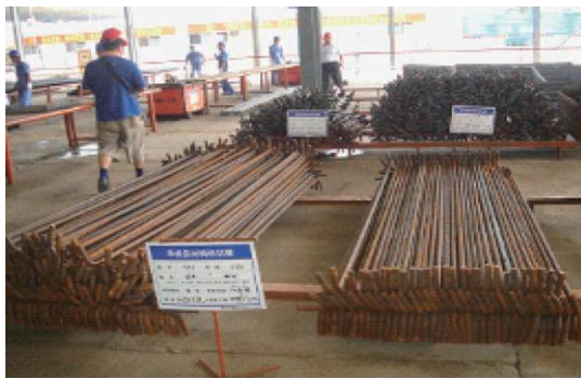
图 1.2.1-2 钢筋半成品分类堆放
