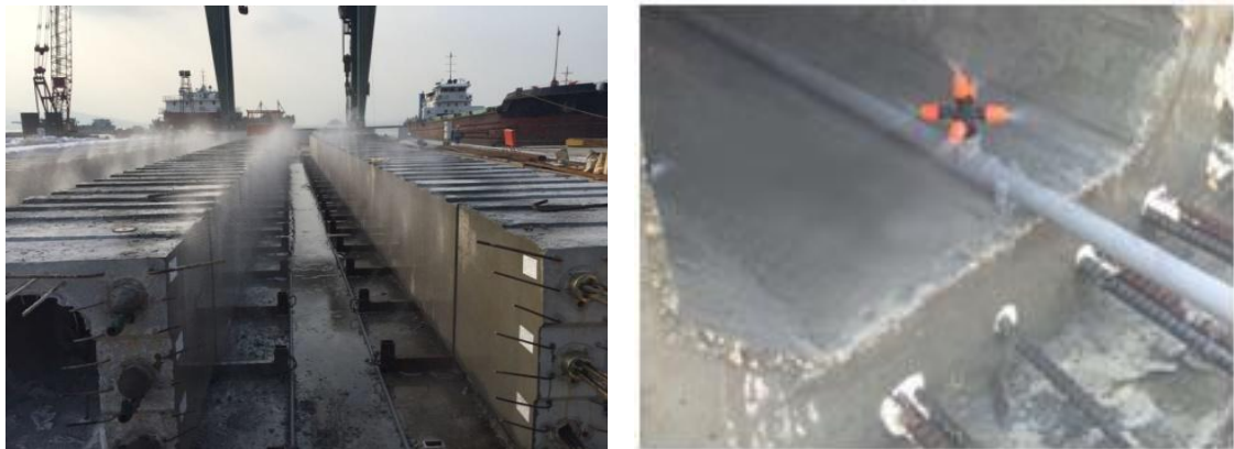
图 2.2.2-3 预制空心板内外腔同步喷淋养护
