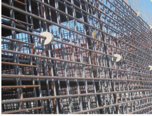
图 1.2.8-5 圆饼形垫块支垫
