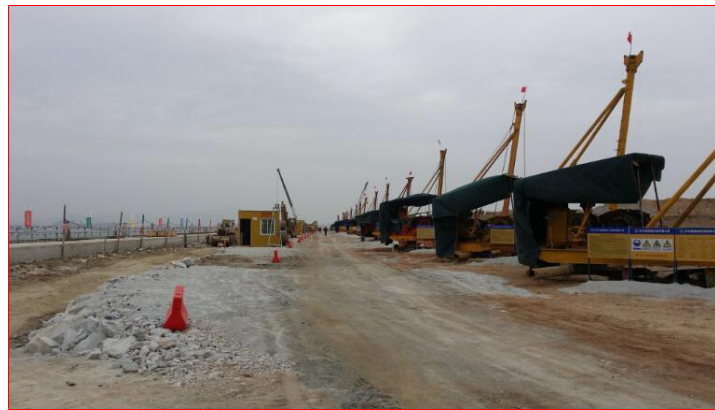
图 2.3.6-4 现场整个灌注桩施工区域总体地面平整,道路平直,场区干净整洁
