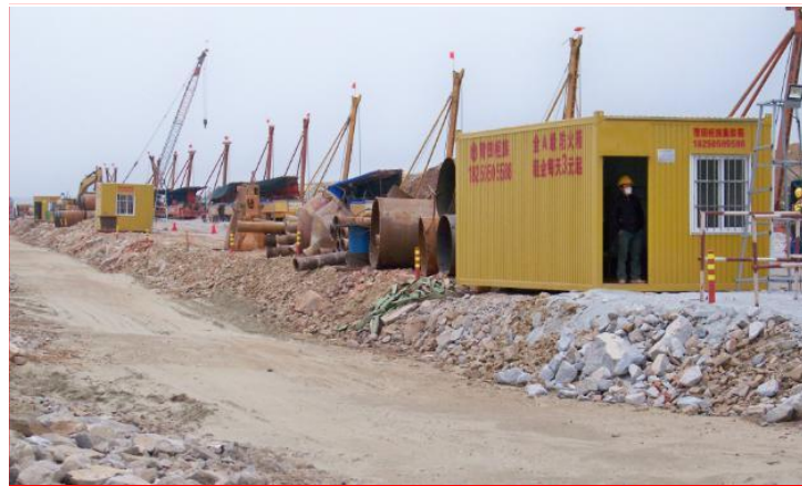
图 2.3.6-3 现场值班室、导管堆放区、护筒堆放区、氧气乙炔库等区域设置在同一直线上
