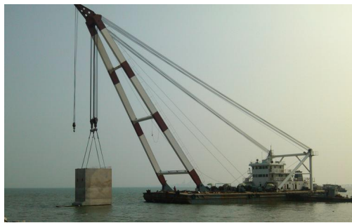
图 1.4.2-5 起重船吊装工艺
