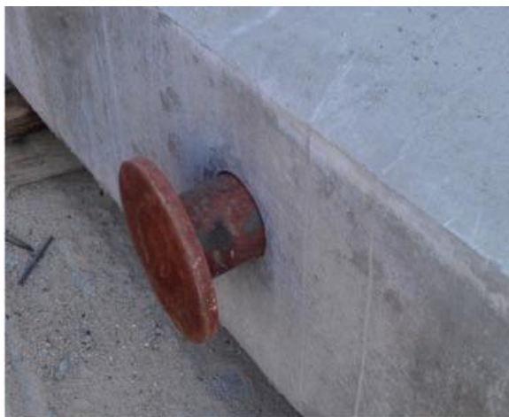
图 2.1.2-4 预埋钢套管
