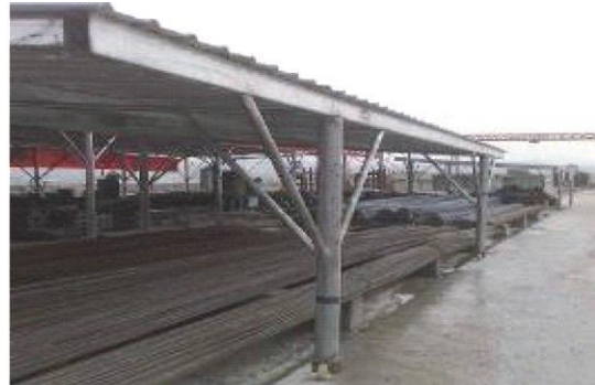
图 1.2.1-3 移动式钢筋堆放棚
