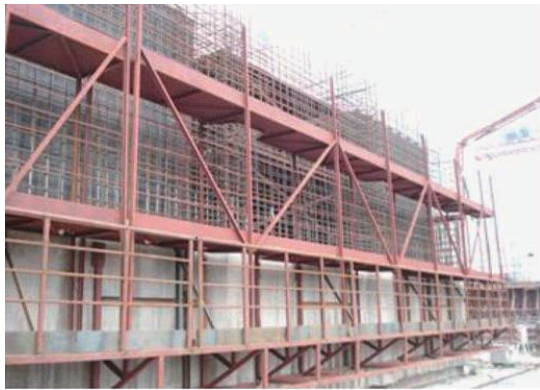
图 1.2.5-11 钢筋绑扎操作平台
