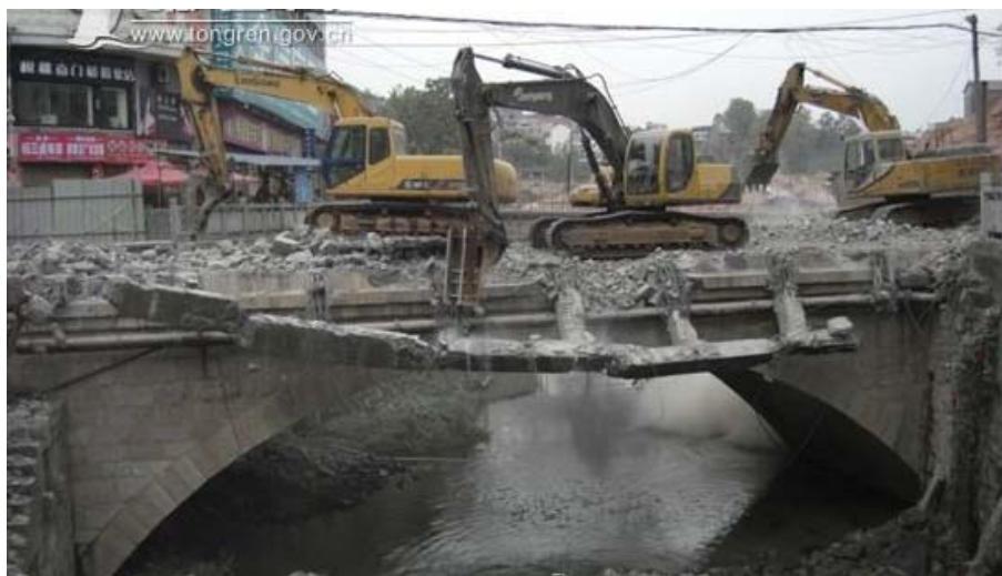
图 4.47 拆除拱桥桥面护栏
