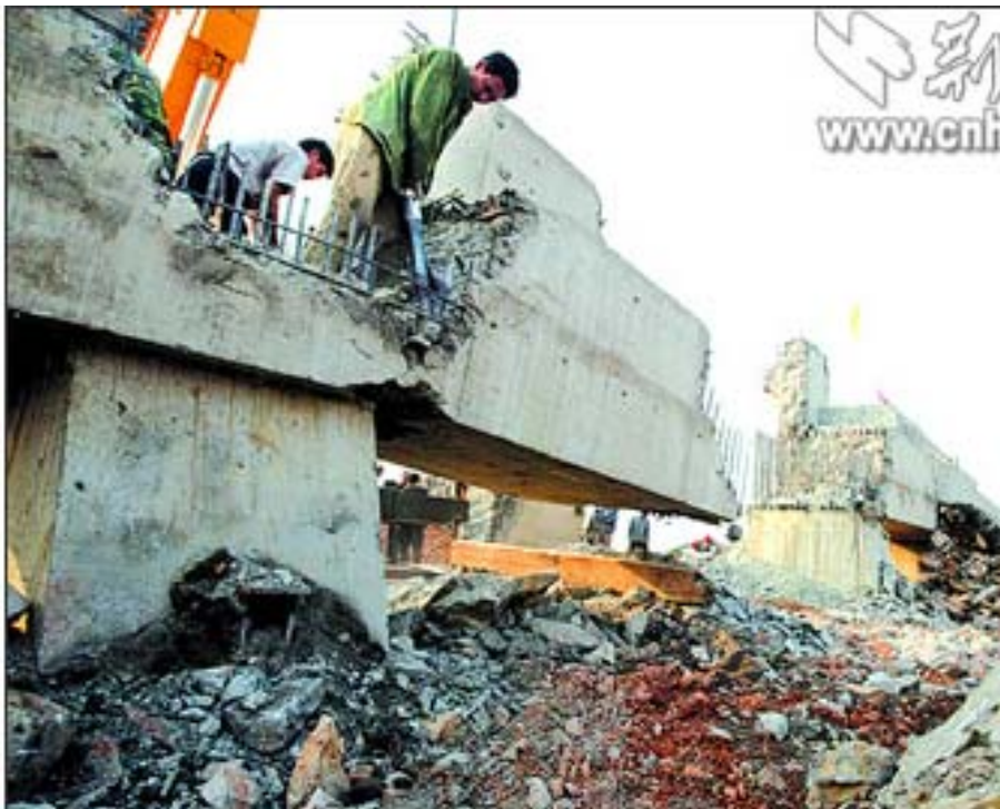
图 4.46 拆除桥梁墩台：用人工或机械拆除桥梁墩台。
