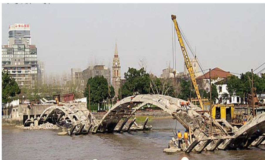
图 4.49 拆除拱桥主拱圈
