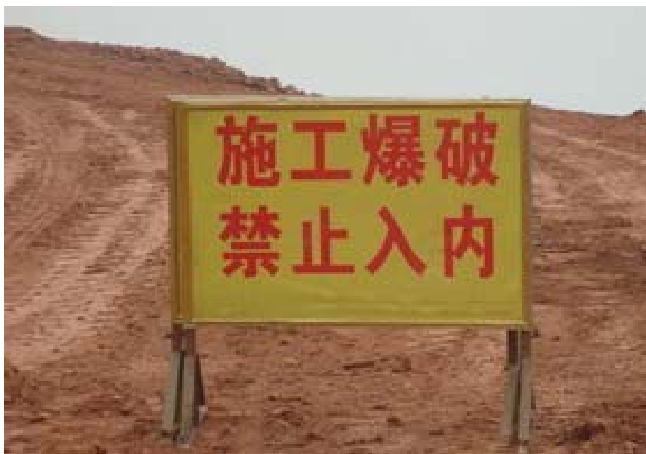
图 6.19 爆破施工警示牌：爆破现场设置警示牌、划出警戒区，并派设警戒人员。
