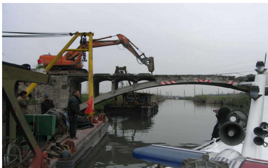
图 4.48 拆除拱桥拱上建筑
