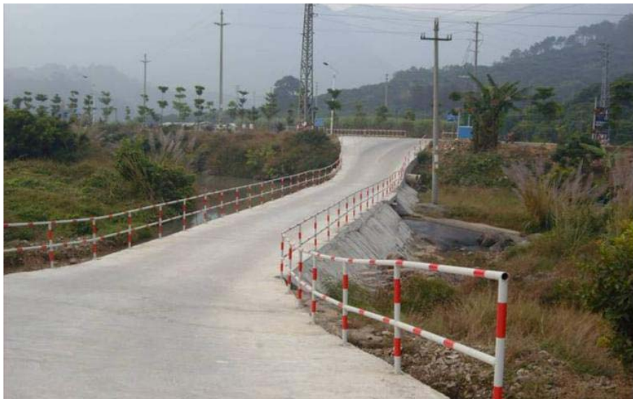
图 6.3 施工便道：施工便道路基宽度一般不小于 4.5m，路面宽度不小于 3.5m，曲线或地形复杂地段应适当加宽。
