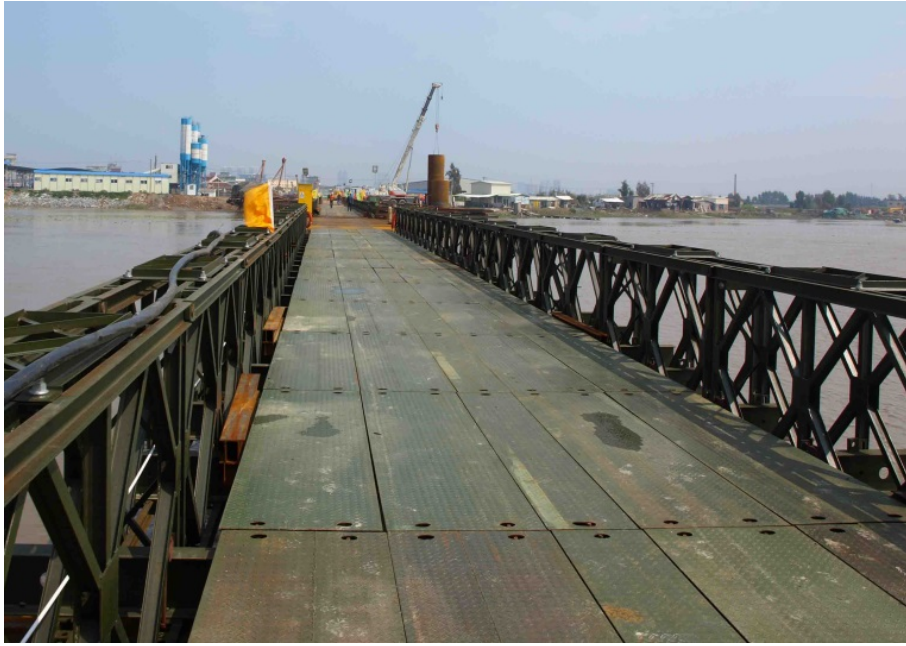
图 6.4 施工便桥：按照实际情况专门设计，同时应满足排洪要求。
