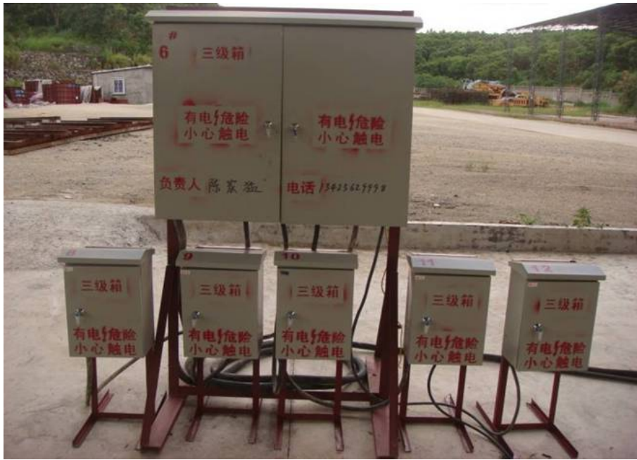
图 6.15 铁制标准配电箱：均编号配锁，标明负责人姓名、联系电话、警示标识。
