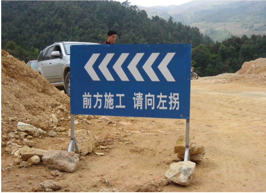
图 6.6 施工路段指示牌：岔路口设置方向指示牌。
