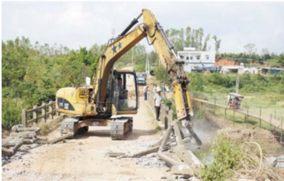
图 4.44 拆除桥面附属：拆除护栏、安全带等附属设施。
