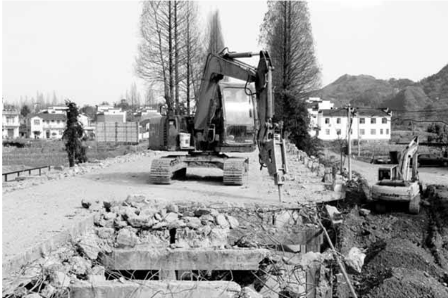
图 4.45 拆除桥面板：用机械拆除桥梁梁板。
