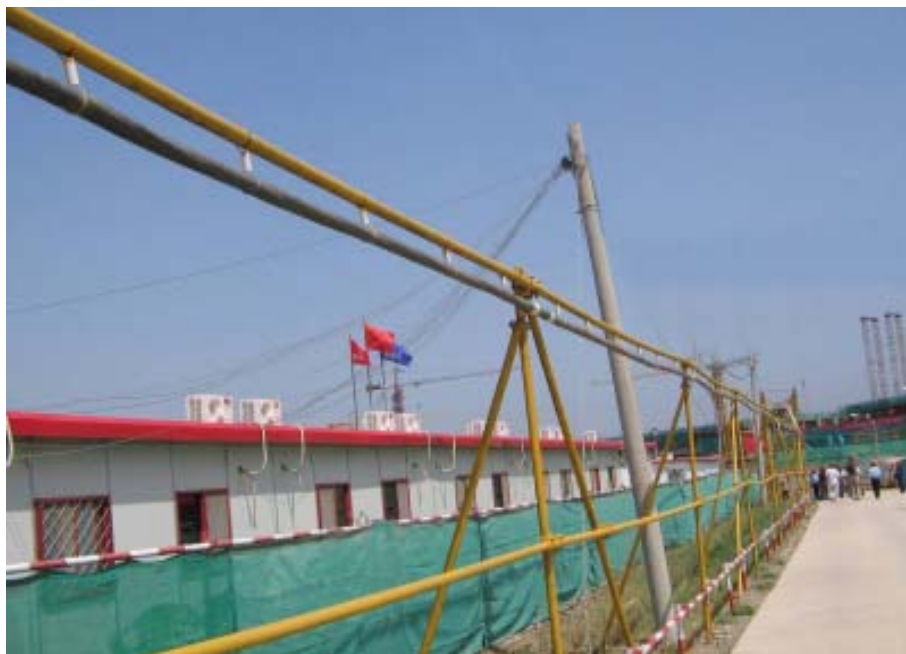
图 6.14 现场电缆：现场使用电缆必须临空架设。
