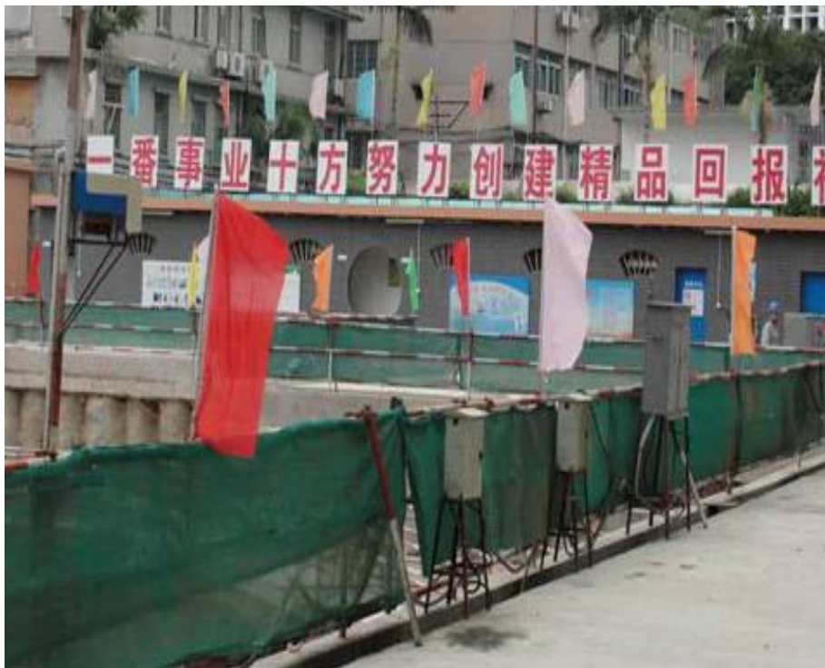
图 6.10 安全网：临边作业必须采用安全防护网。
