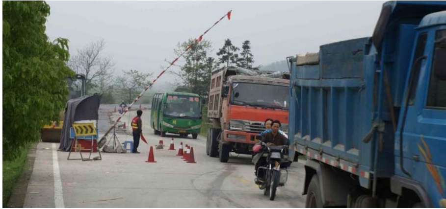
图 6.1 交通专人维护岗亭：改扩建项目边施工、边通车时应设置。
