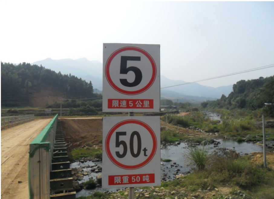
图 6.5 施工便道（桥）警示标志：便道急弯速度、便桥承载等应设安全警示标志。
