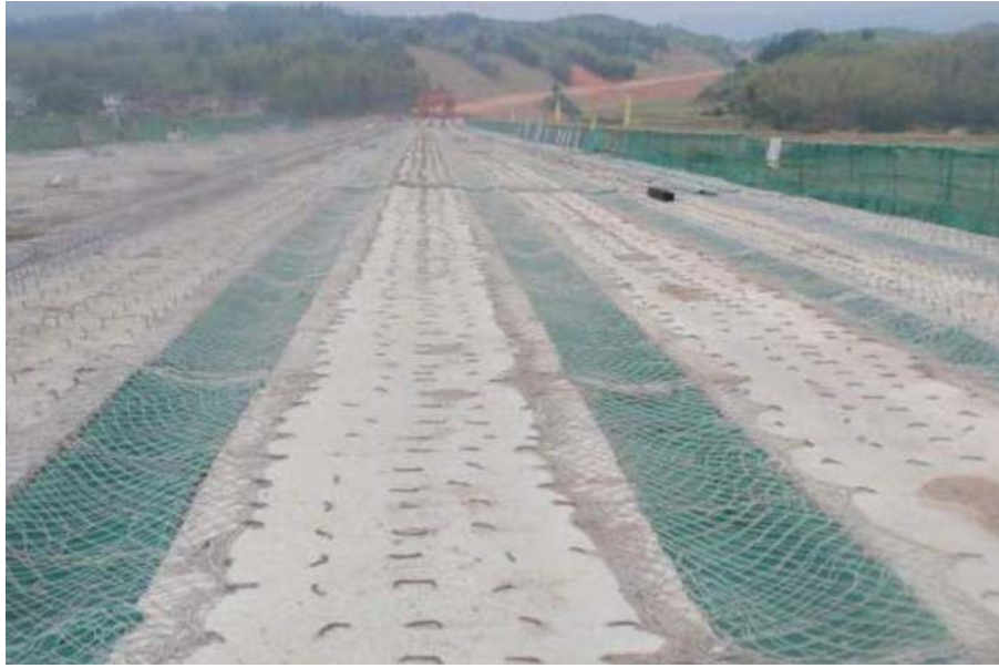
图 6.11 桥梁上部结构安全防护：桥梁边缘及宽桥间应及时设置安全网，做好临边防护，防止高空坠落，维护施工安全。
