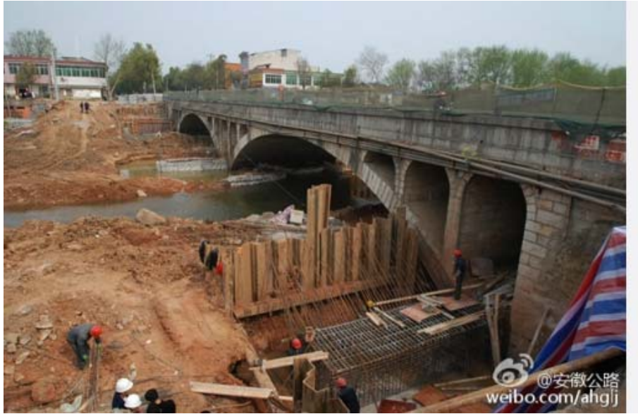
图 4.43 拱桥拼宽：桥台设置必要的支护
